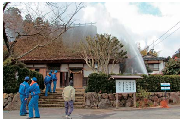
億岐家住宅での放水試験の様子
